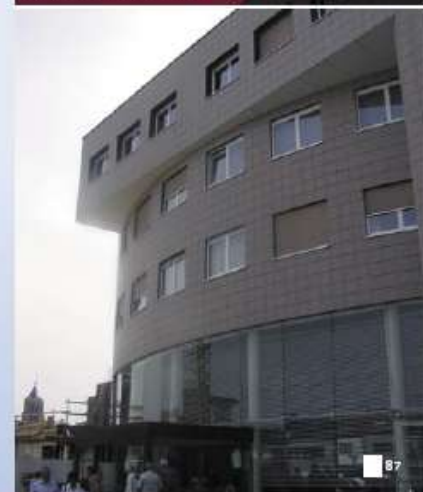
De nieuwe goed werk terracotta gevelbouw wordt met sterk, zorgt voor een totaal andere sfeer van het ziekenhuis.
